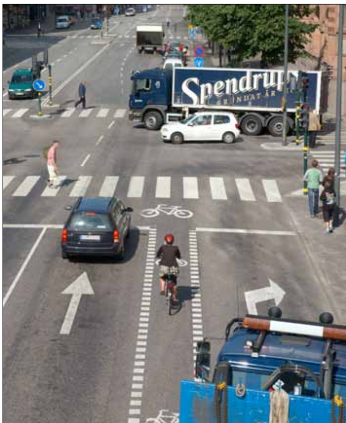
Bilden visar ett cykelfält som leder fram till en cykelbox. En lastbil kör in till höger om cyklisten som kan ställa sig framför lastbilen i cykelboxen om också hon ska svänga höger eller smidigt fortsätta rakt fram utan att hamna i konflikt med det högersvängande fordonet.
